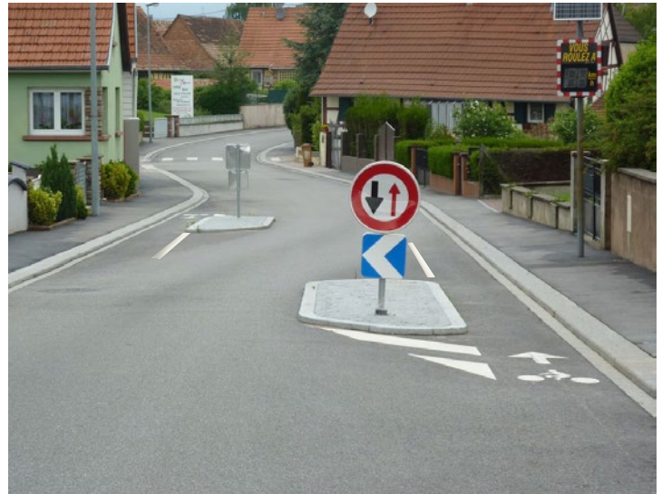
Aménagement d'une double écluse en zone 30. En cas d'écluse des aménagements latéraux (by-pass) peuvent être réalisés pour les cyclistes
